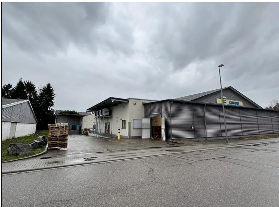
Abbildung 8: Zufahrt für die Warenanlieferung
