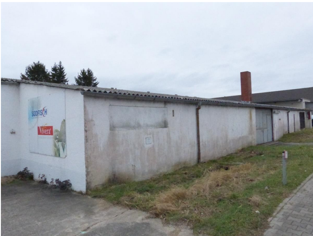
Bild 2: Ansicht der Lagerhalle von der Wilhelmstraße.
