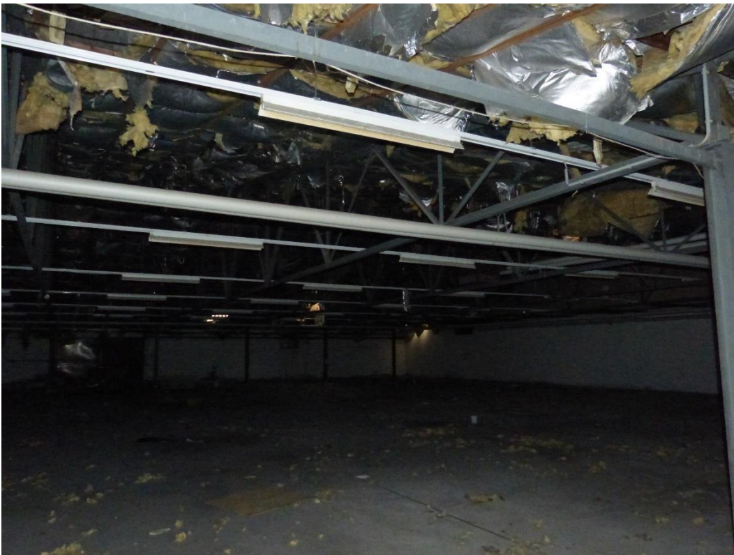
Bild 4: Lagerhalle von innen.
