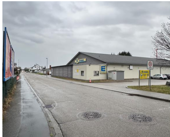
Abbildung 7: Beidseitiger Gehweg in Wilhelmstraße
