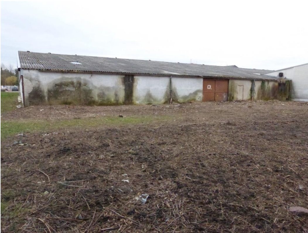
Bild 3: Rückseite der Lagerhalle von nordwestlicher Richtung.
