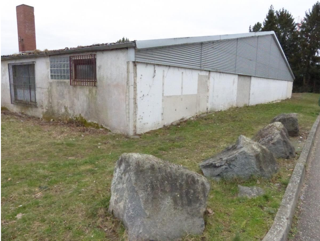
Bild 1: Nordostseite der abzubrechenden Lagerhalle auf Flurstück 1332/16.
