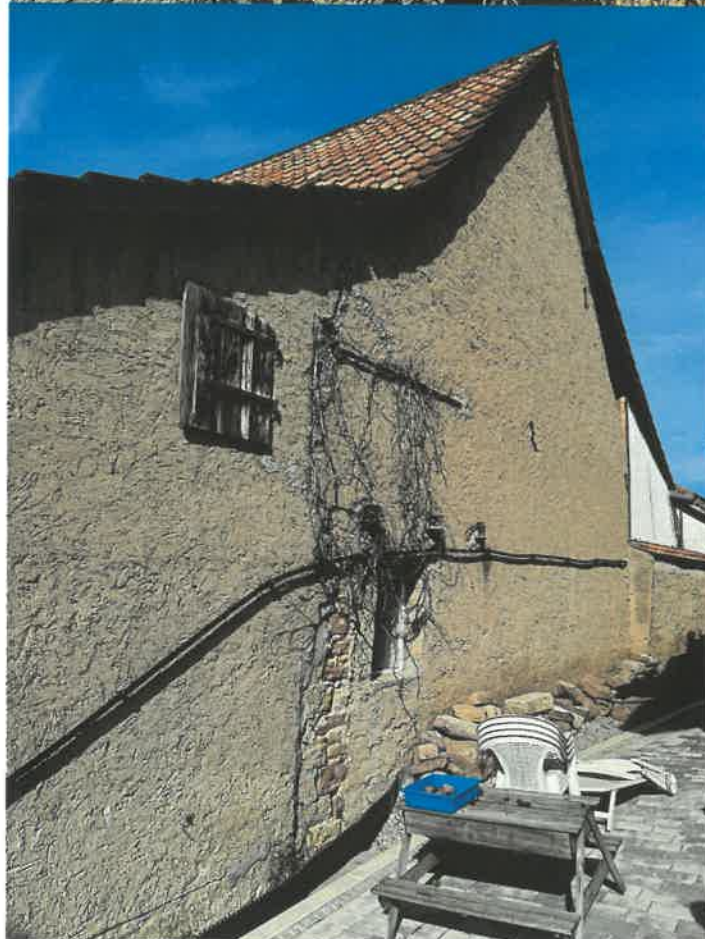
F4 Südostgiebel Übergang Scheune - Anbau
