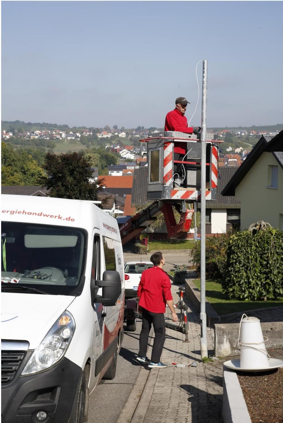
Bild: Fachunternehmen bei den Arbeiten zur Umstellung auf die LED-Straßenbeleuchtung
