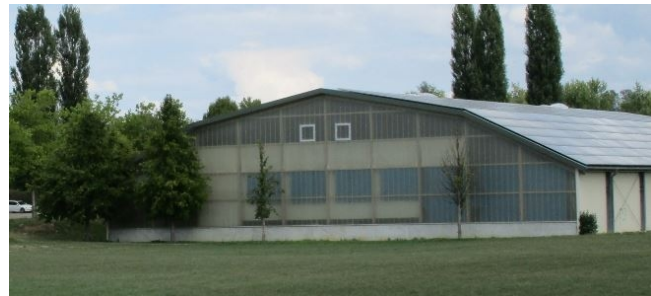
Abbildung 8: Blick auf die vier entfallenden Bäume neben der Tennishalle.
