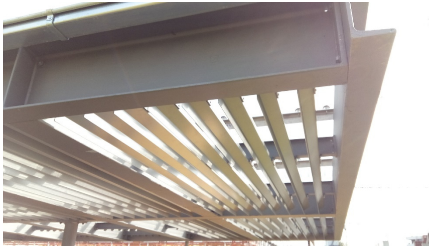
Dach TG Ausgang Bürgerpark
