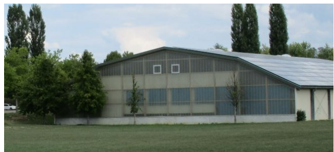
Abbildung 13: Blick auf die vier entfallenden Bäume neben der Tennishalle.
