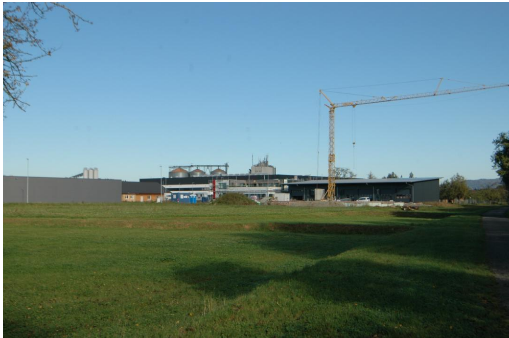
Rasenmulden als Retentions- und Versickerungsflächen, im Hintergrund das Gewerbegebiet `Neufrach – Ost III`
