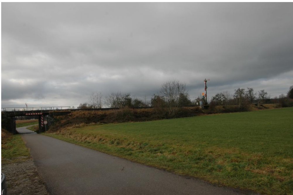
Blick von Osten auf die Böschung des Bahndamms
