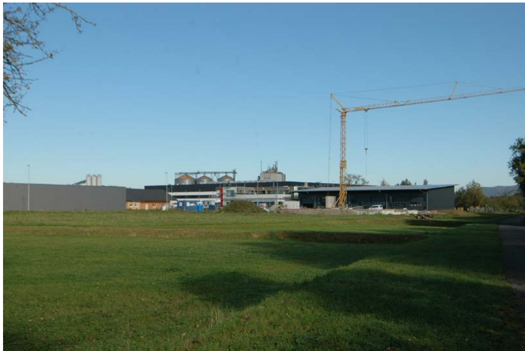
Rasenmulden als Retentions- und Versickerungsflächen, im Hintergrund das Gewerbegebiet `Neufrach – Ost III`
