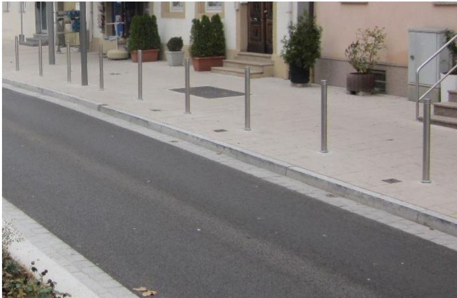
Zufahrtsverhinderung Marktplatz – indirekter Schutz
