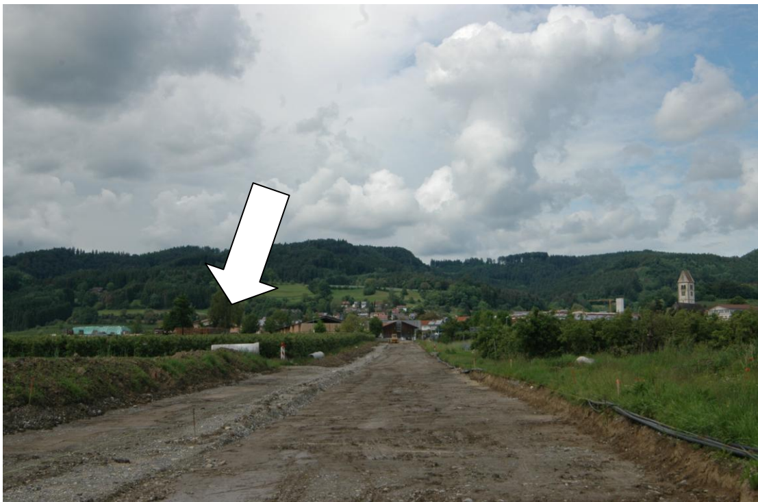
Blick auf den Änderungsbereich, in der Bildmitte die im Bau befindliche Straße zwischen südlichem Ortseingang und Gewerbegebiet, ganz rechts der Kirchturm der St.-Martins-Kirche
