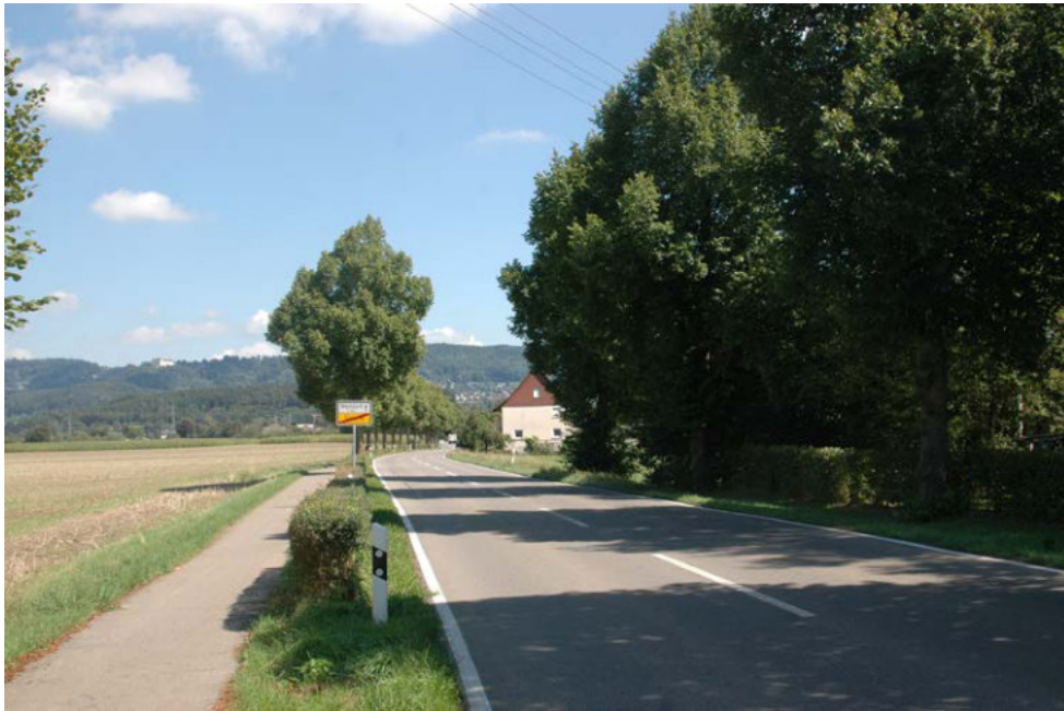
Landesstraße 201 von Südwesten
