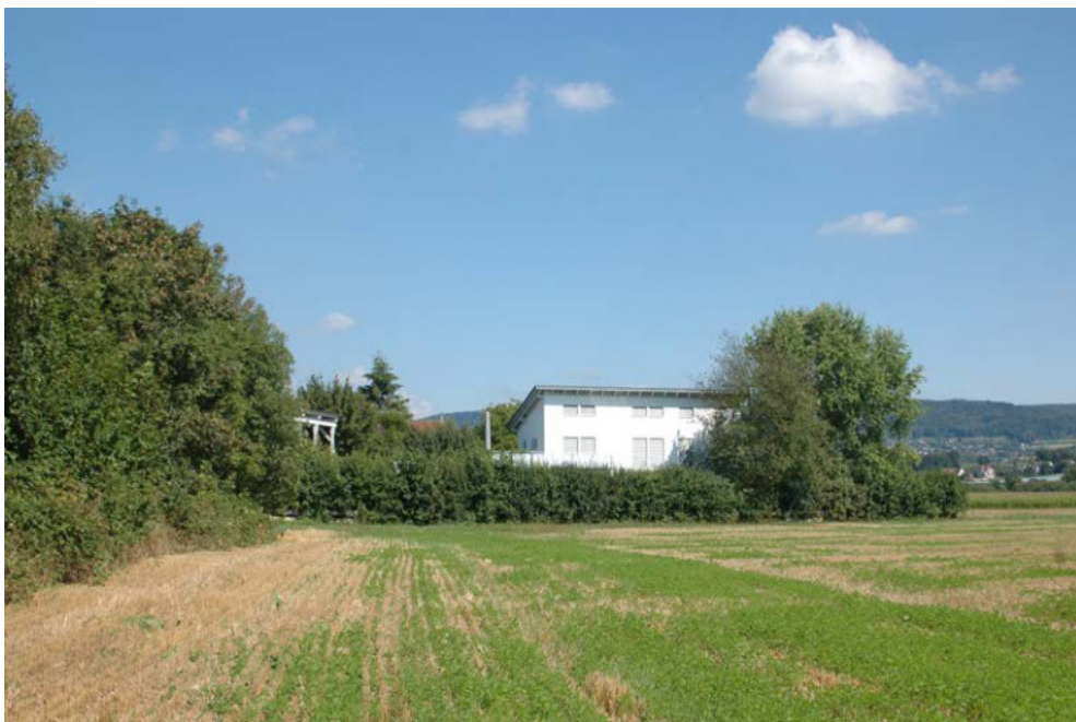
Blick von Süden, links die Gehölzstruktur entlang der Straße `Weildorfer Hardt`, in der Bildmitte der bestehende Gewerbebetrieb
