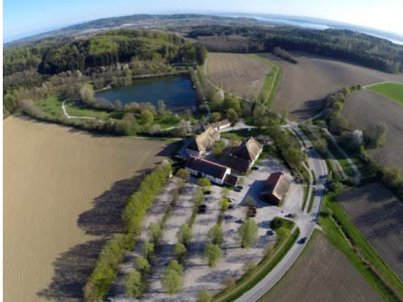
Blick aus Richtung Norden auf den Mendlishausenerhof mit gleichnamigem Weiher, bestehendem Parkplatz und angrenzender Ackerfläche
