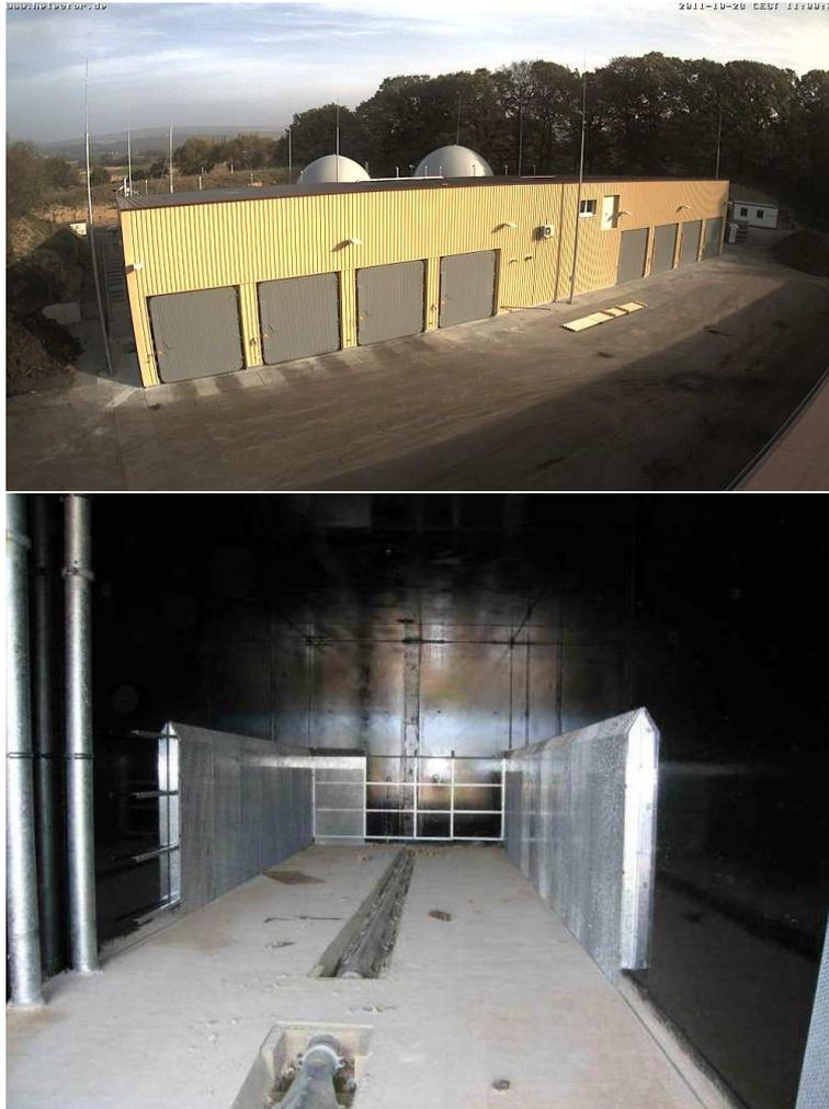
Abb. 30: Vergärungsanlage Lohfelden (LK Kassel) und Innenansicht eines Boxenfermenters
