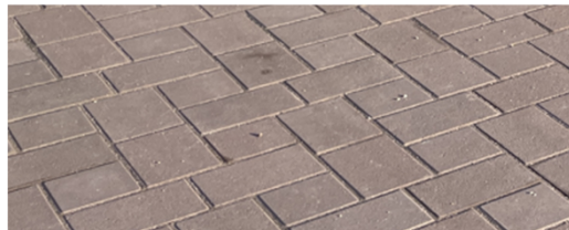
Pflaster im Straßenbereich (Bestand)
