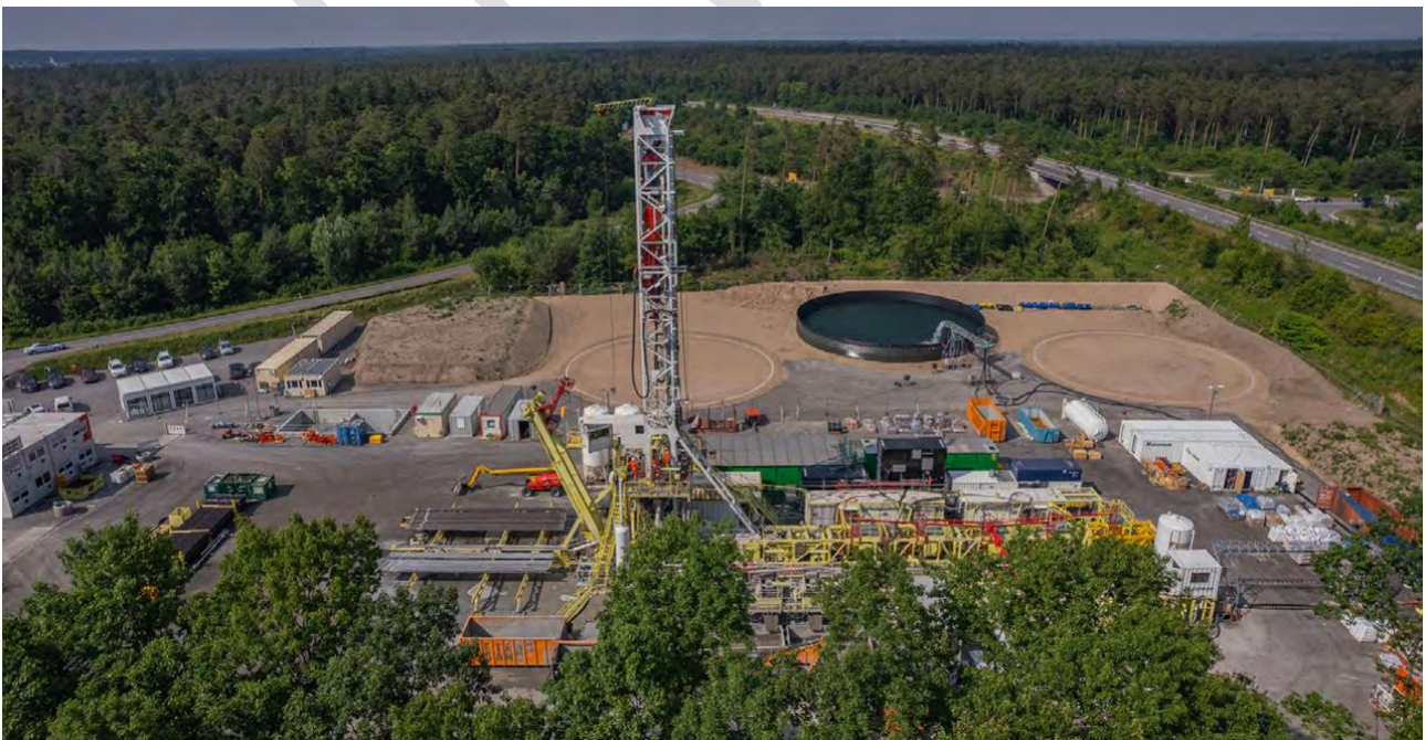
Abbildung 23: Drohnenaufnahme des Bohrplatzes in Graben-Neudorf (Deutsche ErdWärme GmbH, 2022)
