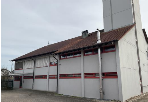
Nord-Ansicht: Auf dieser Seite des Gebäudes befinden sich hauptsächlich Umkleidekabinen, Duschräume und Büroräume
