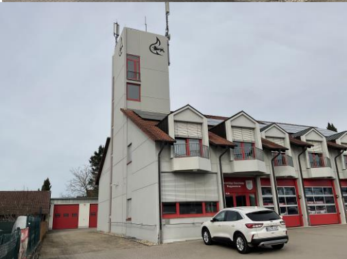
West-Ansicht: Die Westseite ist mit einer Betonvorwandschale versehen. Auf dieser Seite befindet sich das Treppenhaus.
