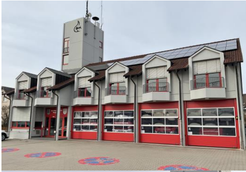
Süd-Ansicht: Mit Eingang zum Gebäude und Garagentoren zu den Einsatzfahrzeugen.
