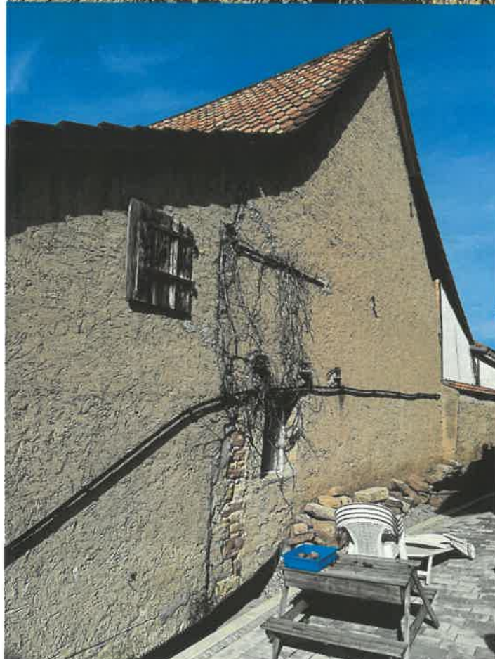
F4 Südostgiebel Übergang Scheune - Anbau
