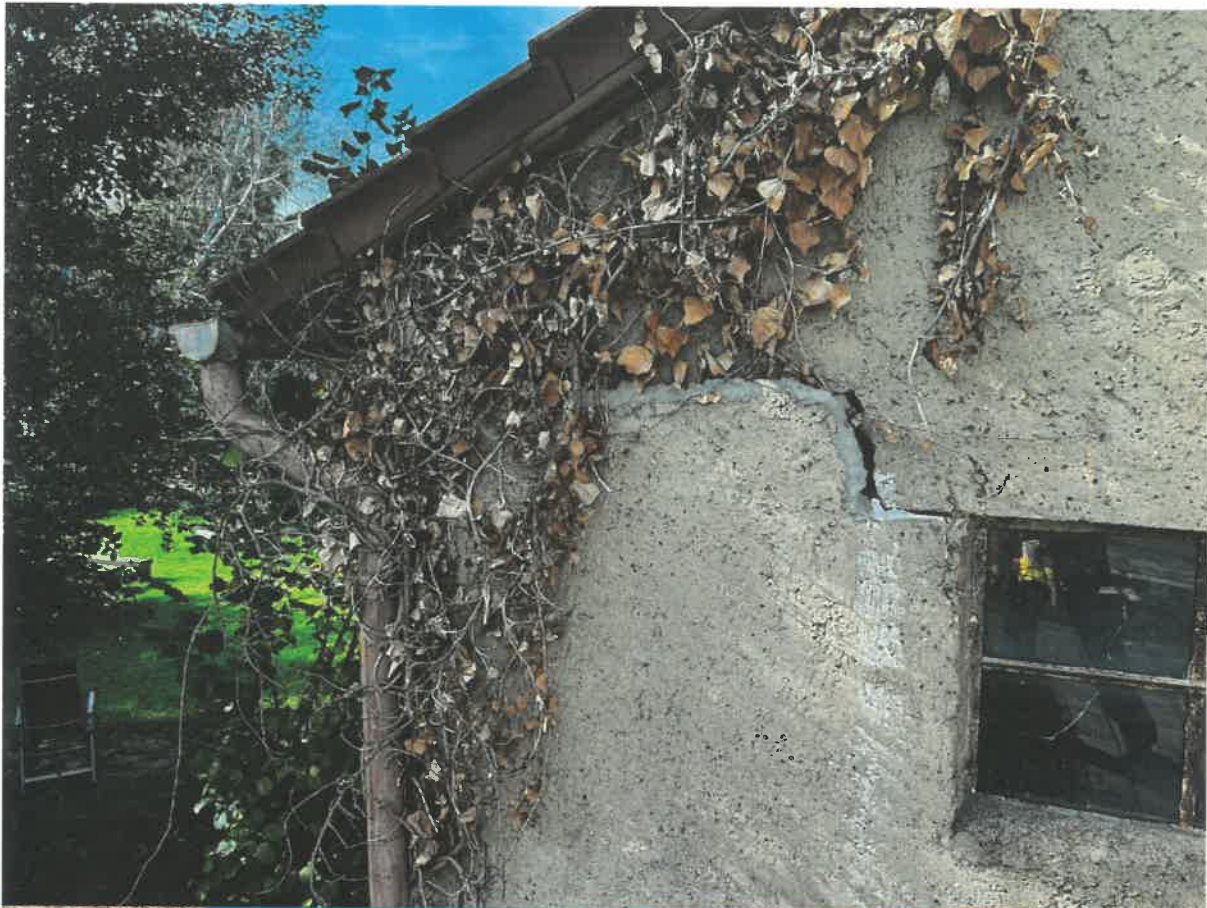
F6 Traufwand Anbau Horizontalriss, Vertikalriss Rissweite ca. 2-3cm
